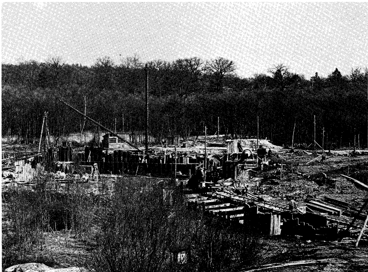
Bygget av slussen pågår 1929. Foto Stockholms hamn
